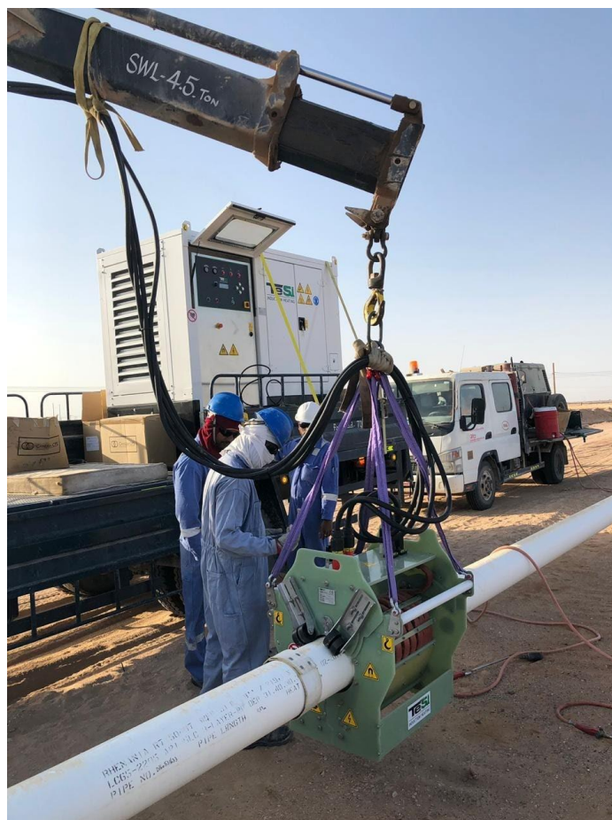
Индукционная катушка предварительного нагрева для термоусадочных муфт из полиэтилена (PE) или полипропилена (PP)
