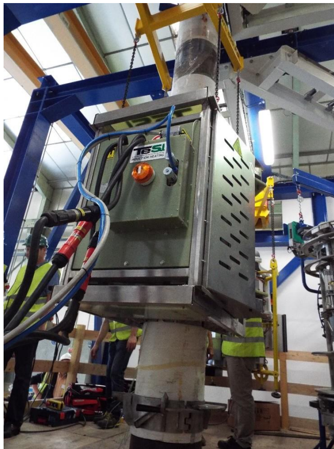
Индукционные катушки для проекта по морским объектам для J-образной укладки труб.
