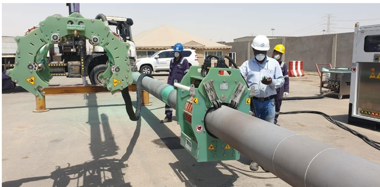
Индукционная катушка предварительного нагрева для расплавленной эпоксидной смолы (FBE)
