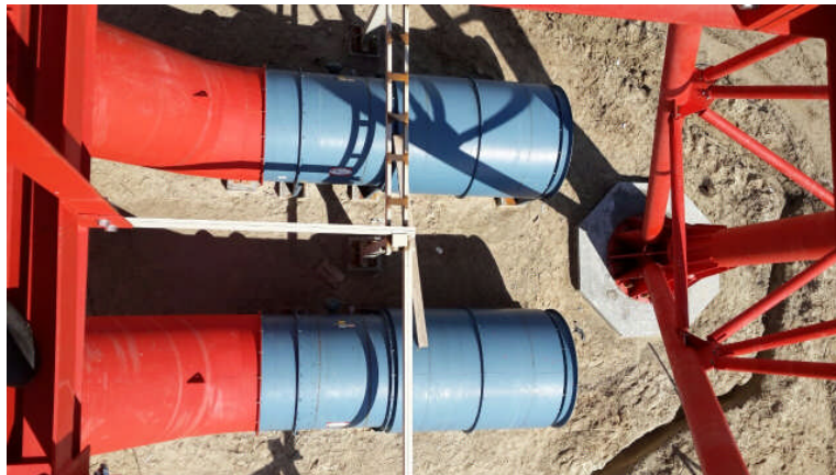
Фото 1. Аксиальные воздуходувки в основании ствола факела.
