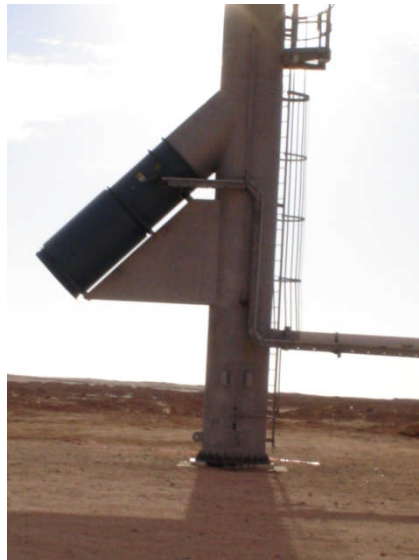
Фото 2. Аксиальная воздуходувка в основании ствола факела.
