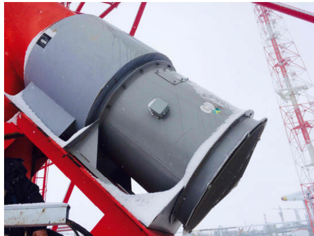
Фото 3. Аксиальная воздуходувка в основании ствола факела.
