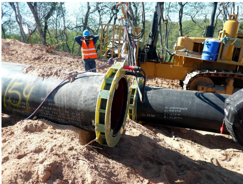
Индукционные катушки внешнего типа для предварительного нагрева.
