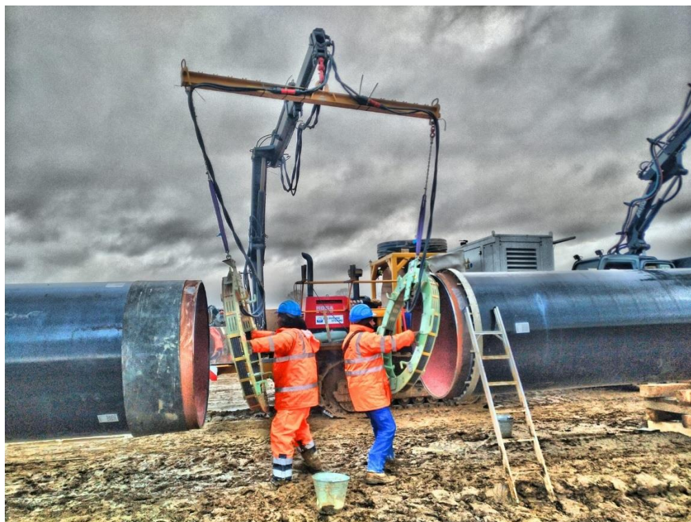
Индукционные катушки внешнего типа для предварительного нагрева.
